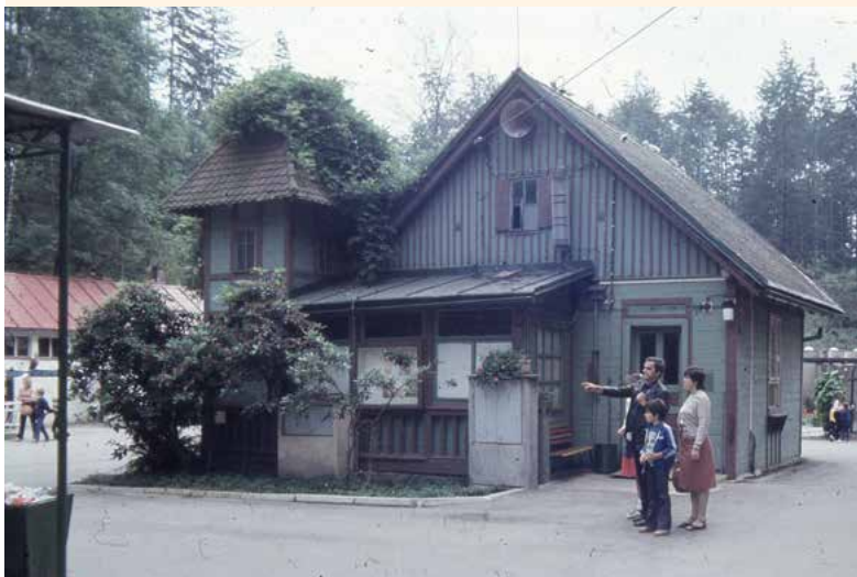
Po vzniku nové provozní budovy sloužil domek i jako zázemí pro pionýrský kroužek. Fotografie z 80. let minulého století
